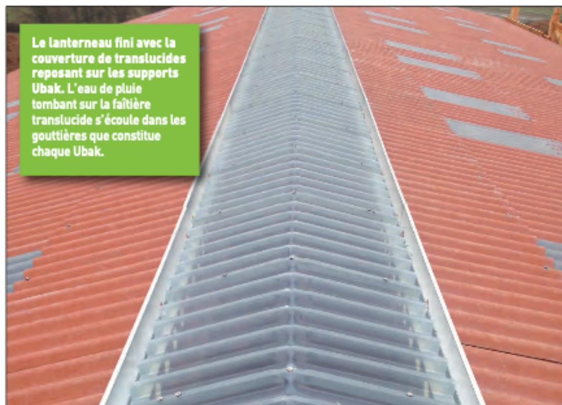
Le lanterneau fini avec la couverture de translucides reposant sur les supports Ubak. L'eau de pluie tombant sur la faîtière translucide s'écoule dans les gouttières que constitue chaque Ubak.
