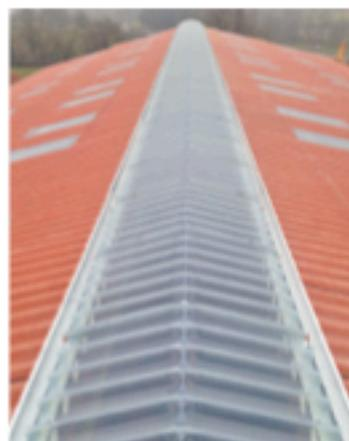
**Le lanterneau fini avec la couverture de translucides reposant sur les supports Ubak.** L'eau de pluie tombant sur la faitière translucide s'écoule dans les gouttières que constitue chaque Ubak.
